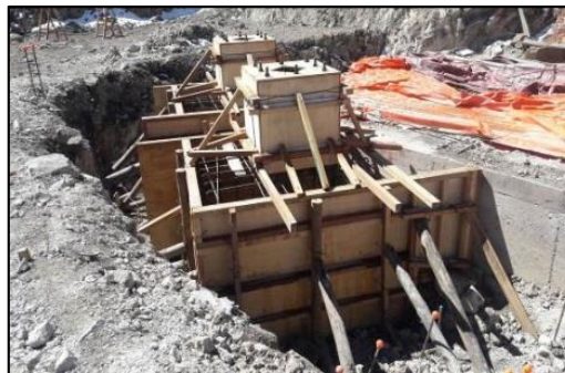
Obras Civiles (2 Semanas)
