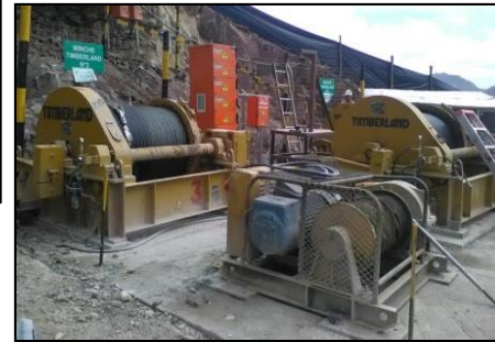
Montaje de Equipos y Estructuras
