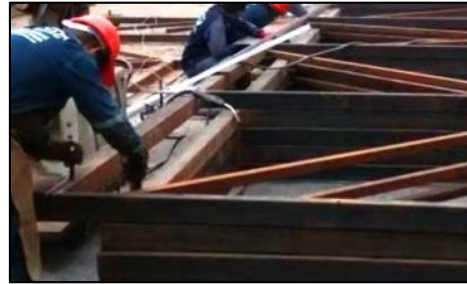
Fabricación de Estructuras Metálicas
